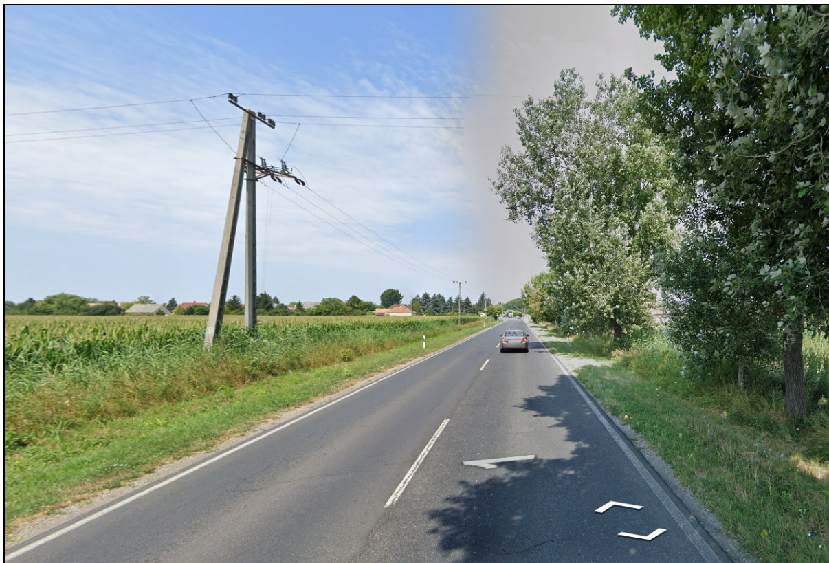
Légvezeték a tervezett kerékpárút 0+056,37 kmsz-ben keresztezi az 1. számú főutat. A törő oszlop a tervezett kerékpárúttal átellenes oldalon van. Forrás: KIRA
